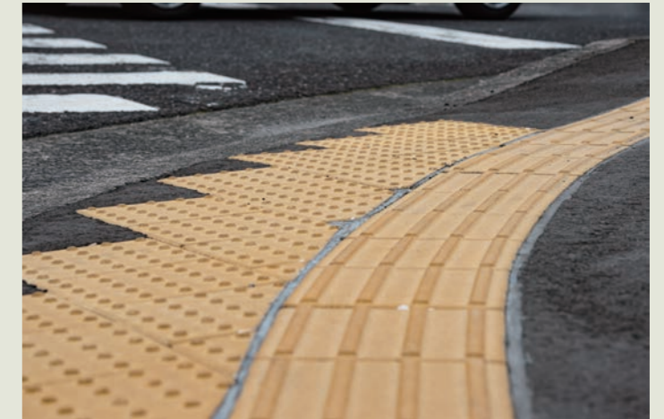
設置した点字ブロック
